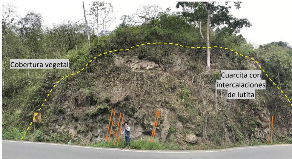
**Figura 58.** Afloramiento de bloques de cuarcita
