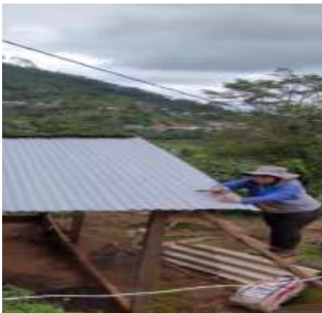
i) Colocación de la cubierta
