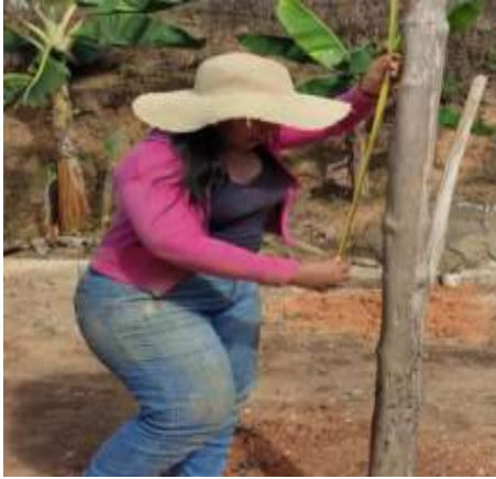
g) Colocación de los postes de madera
