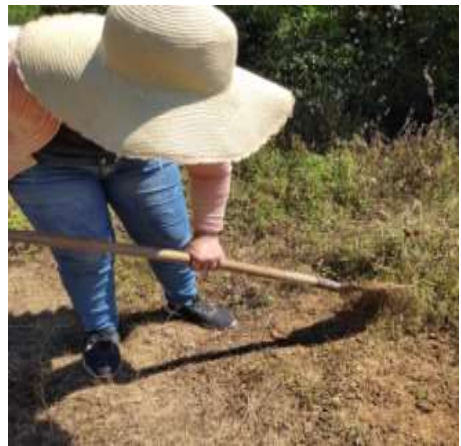
b) Adecuación del área de trabajo
