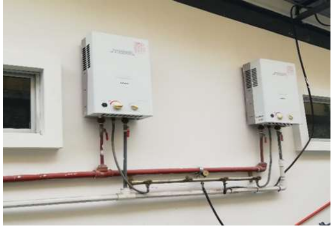
Figura 30. Calefones del sistema actual para el calentamiento del agua de la piscina terapéutica (El autor) (Compra Ecuador, n.d.)
