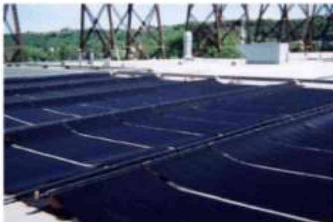
Figura 12. Colector de placa plana sin cubierta (Placco et al., 2020).
