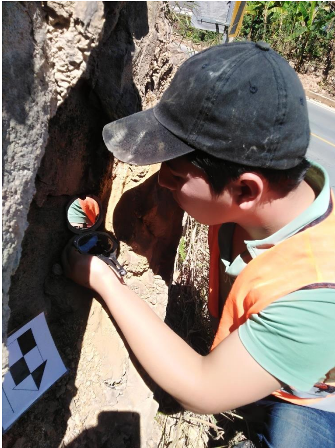
Fotografía 2. Medida de elementos estructurales.
