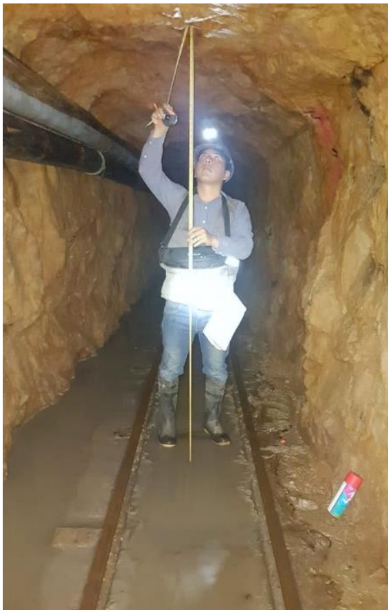
Fotografía 1. Dimensiones de la galería.
