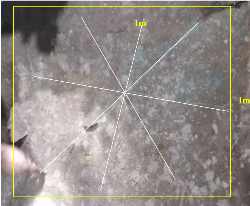
Fotografía 6. Malla de puntos para esclerómetro. Fuente: El Autor, 2022
