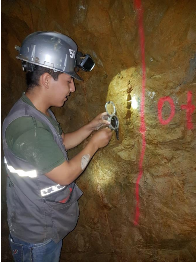
Fotografía 3. Medida de elementos estructurales de la galería.
