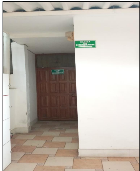
Fig. 15.- “Salida de Emergencia”
