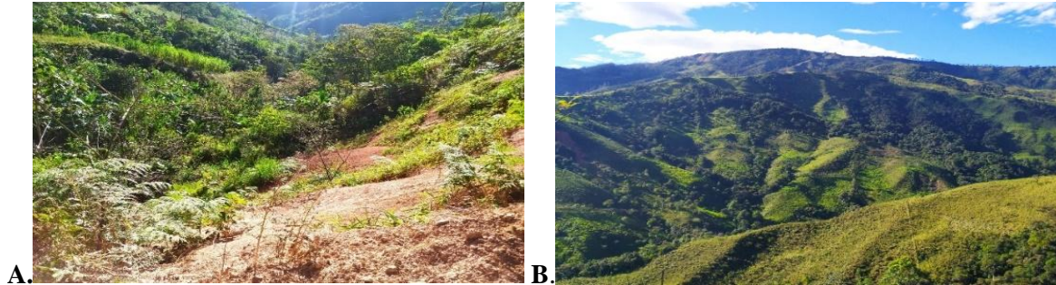
Figura 39 A). Grado erosivo en relieve cóncavo B). Zonas altas que benefician a un drenaje vertical
