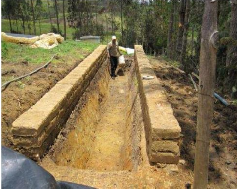
Figura 14 Excavación y conformación de la zanja Nota: Adaptada de (Cotrina, 2011)
