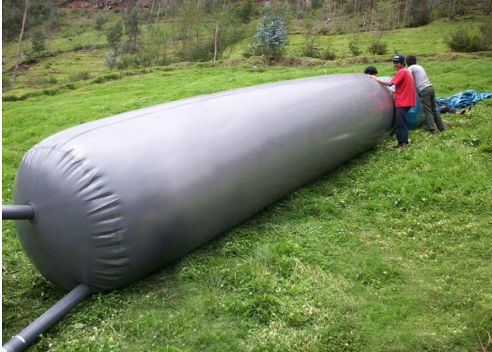
Figura 16 Biodigestor tubular de geomembrana
