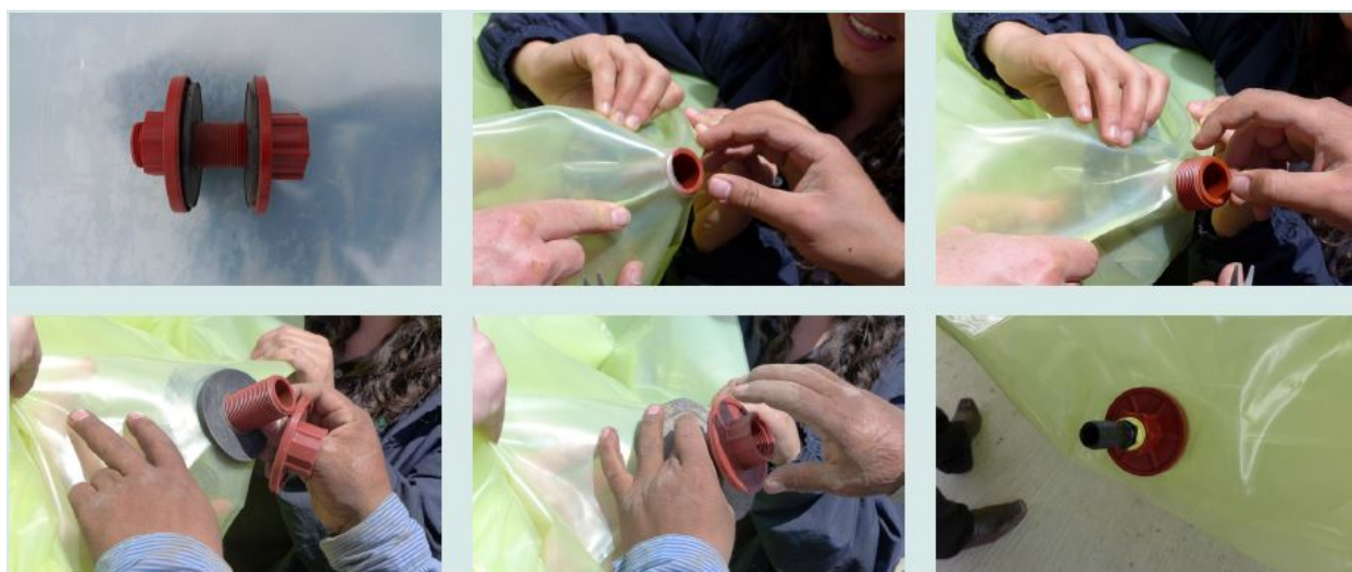
Figura 17 Instalación de la salida de biogás Nota: Adaptada de (Martí Herrero, 2019)
