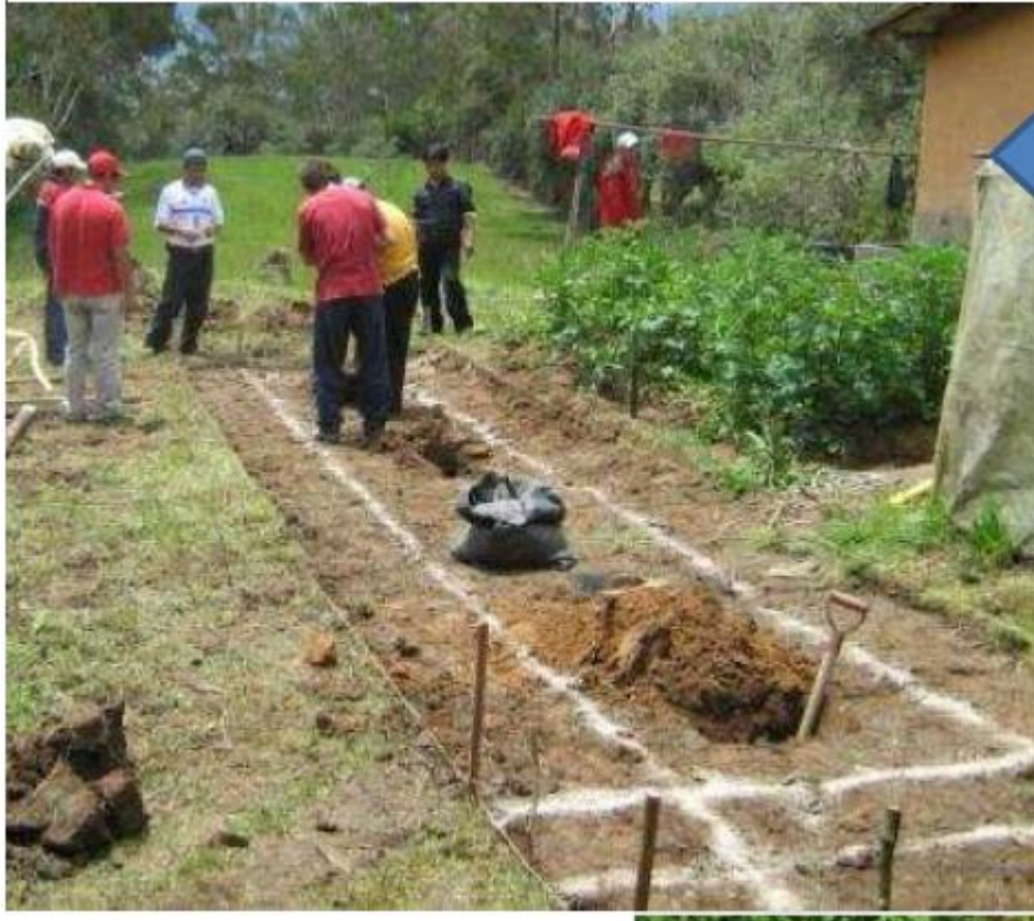
Figura 13 Replanteo para excavaciones Nota: Adaptada de (Cotrina, 2011)
