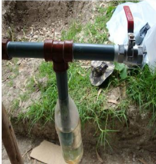
Figura 18 Válvula de alivio de biogás Nota: Adaptada de (Reinaldo et al., 2010)
