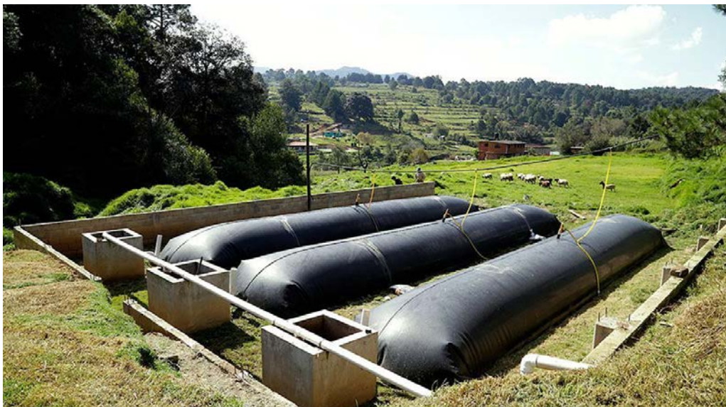
Figura 7 Biodigestor tubular de geomembrana Nota: Adaptada de (Martí Herrero, 2019)
