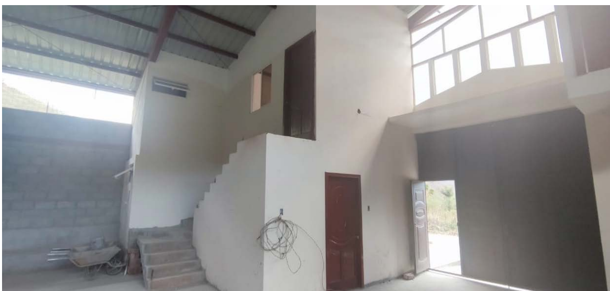
Figura 30 Vista del área administrativa
