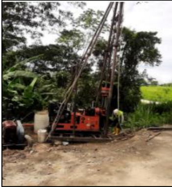
Figura 23. Equipo para los sondeos geotécnicos.
