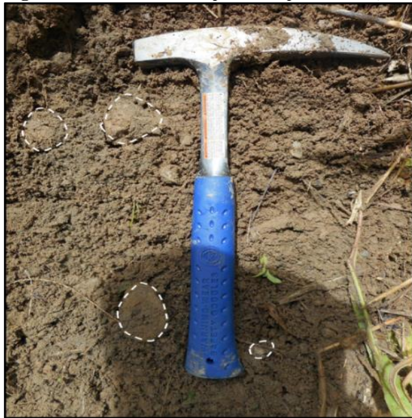
Figura 33. Material antrópico de tipo aluvial (absc. 0+200, margen derecho del tramo vial).
