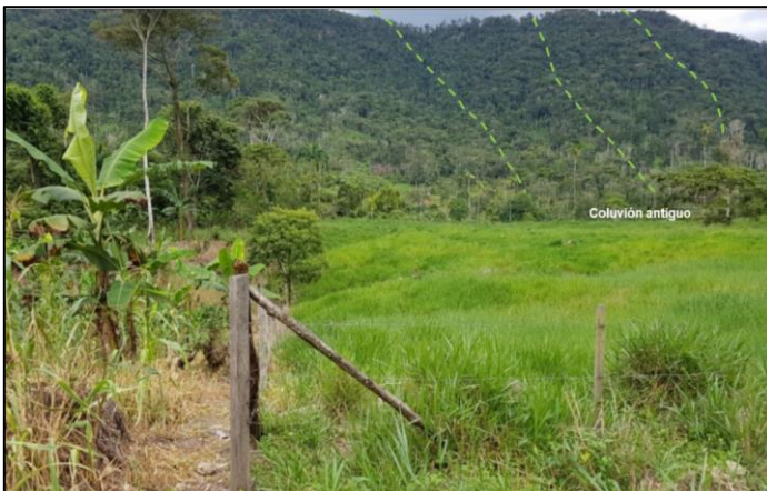
Figura 13. Vista panorámica de un depósito de coluvión antiguo en la absc. 8+900 limitado por vertientes rectilíneas.
