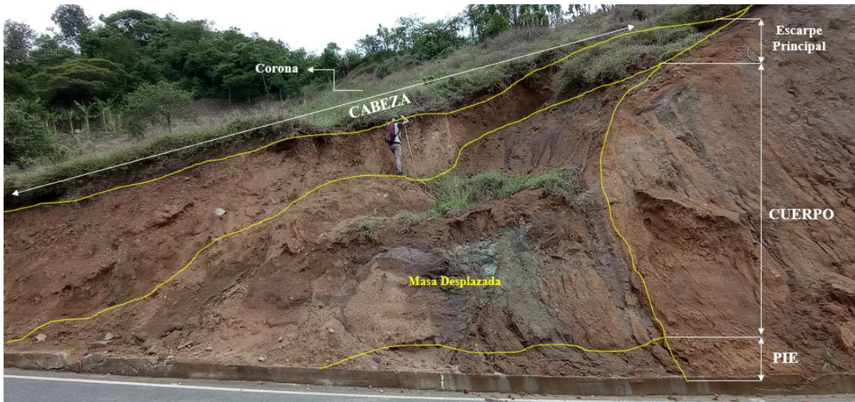
Figura 58. Deslizamiento No.1 en la vía Amaluza-Bellavista
