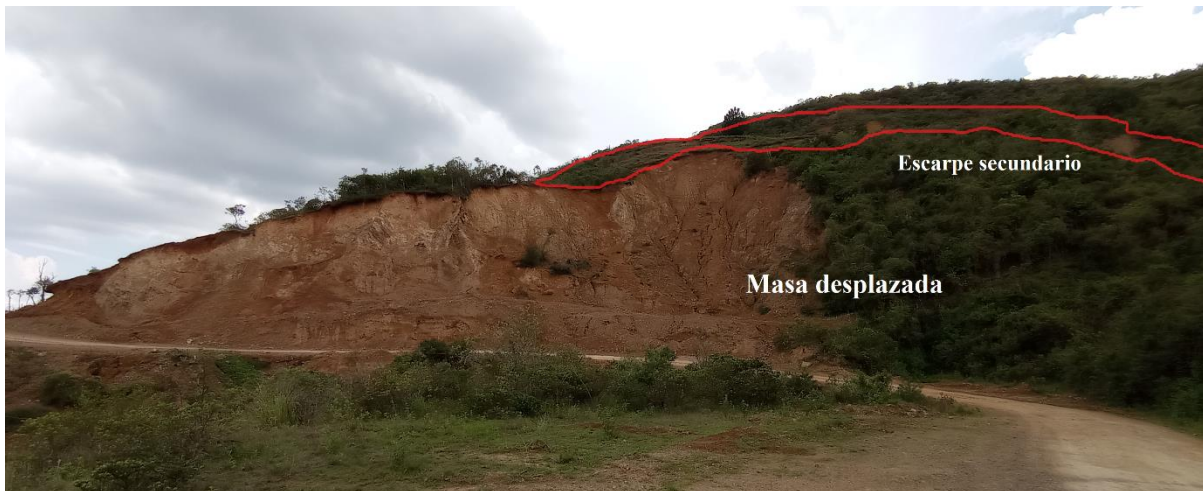
Figura 63. Deslizamiento No. 5 (flanco oeste), intervenido por maquinaria pesada
