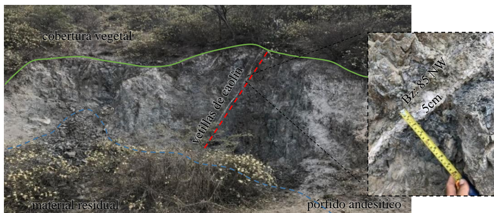
Figura 34: Vía a Illaca, presencia de un pórfido andesítico, vetilla de caolín que atraviesa la estructura
