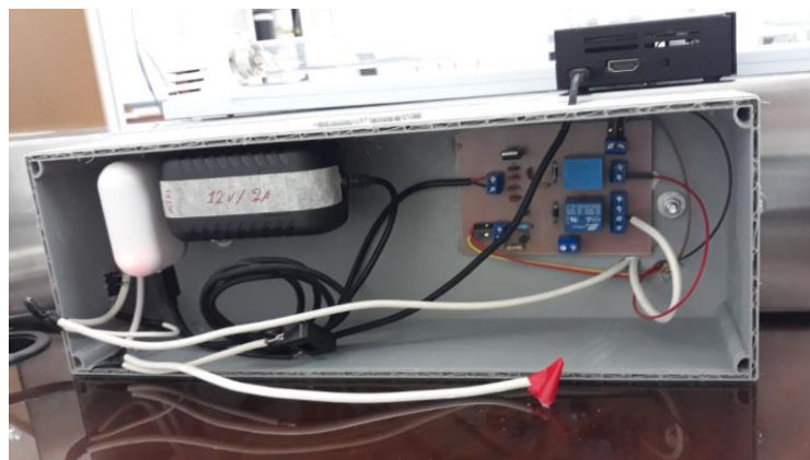
Figura 18. Vista final de la conexión electrónica
