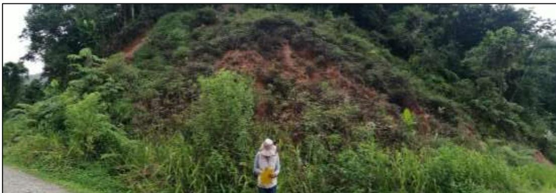
**Fotografía 24.** Deslizamiento identificado en la abs. 6+220 a 6+245, constituido de sábulo.
