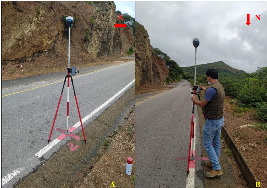
Fotografía 1: Puntos geodésicos de control ubicados en la vía. A (Colocación de equipos), B (Toma de puntos)
