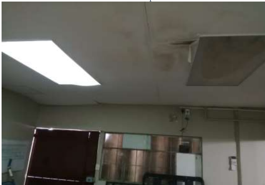
Figura 23 Estado actual de luminaria de los laboratorios de Geología. Fuente: Propia
