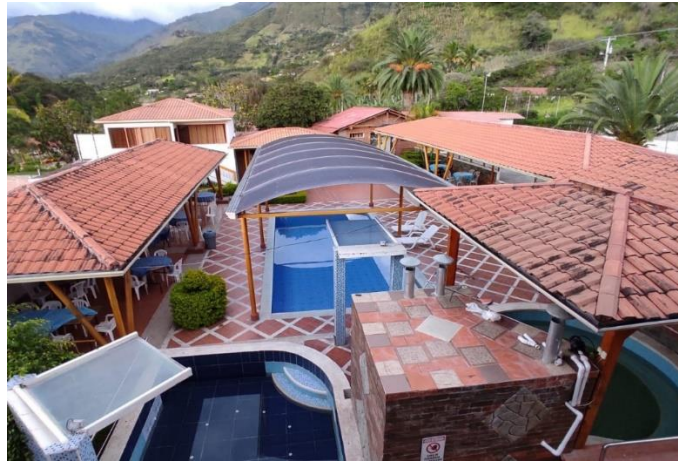
Figura 4 Estado actual de la Hostería El Remanso,
