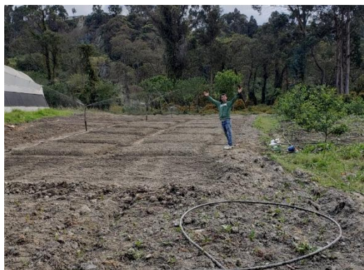
Figura 7. Prueba sistema de riego instalado
