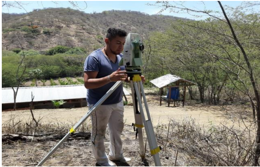
Figura 19. Levantamiento topográfico del área de estudio.
