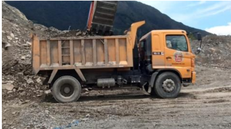
Fotografía 11 Carga de material en la volqueta de 8m 3
