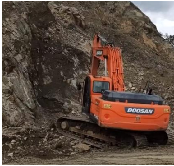
Fotografía 7 Arranque de material para muestreo, con ayuda de la excavadora
