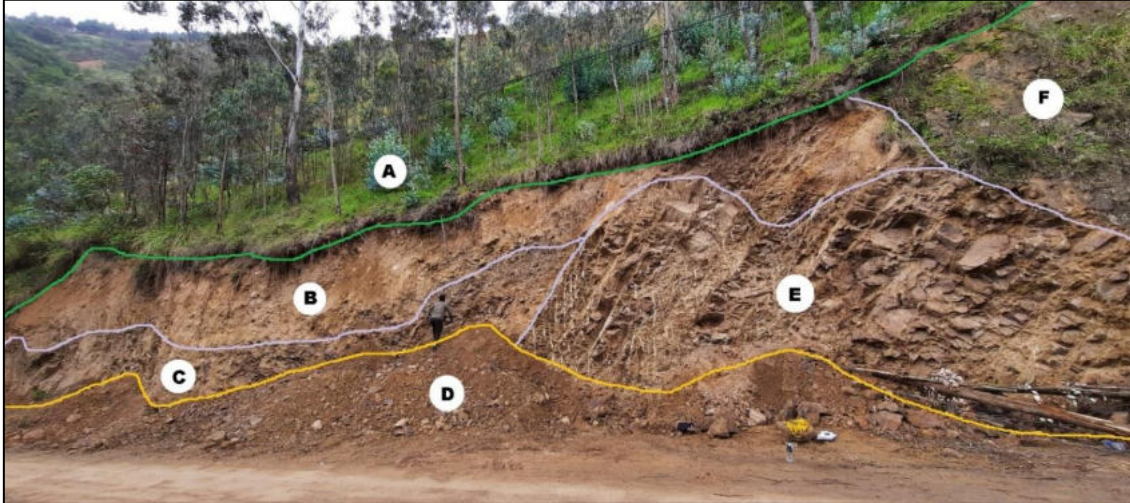
Fotografía 9. Depósito coluvial, ubicado en el barrio La Dolorosa
