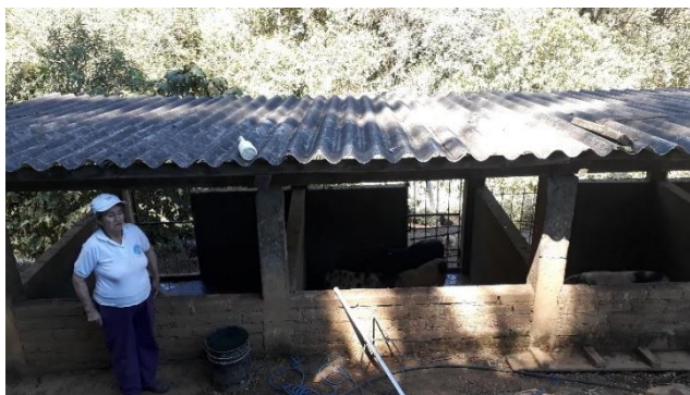
Figura 2. Infraestructura de una chanchera de cemento y zinc. Colaisaca-Calvas.
