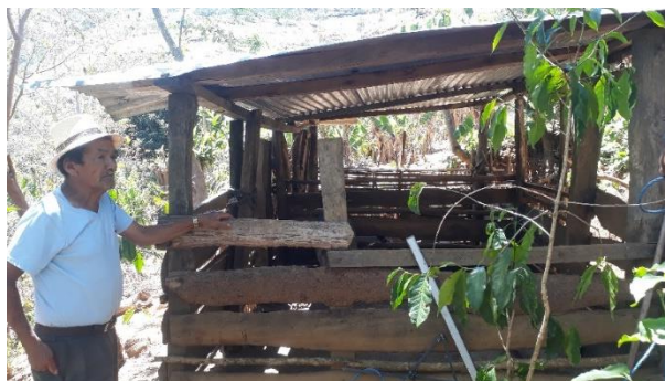
Figura 3. Infraestructura de una chanchera de madera y zinc. Cariamanga-Calvas.
