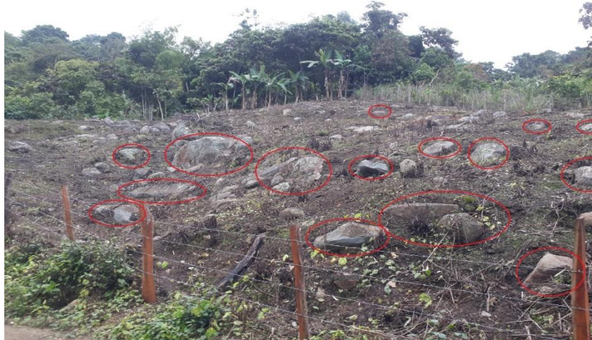
Figura 15. Afloramiento de Depósito Coluvial en el barrio Caminuma.
