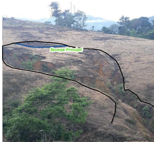
Fotografía 6. Deslizamiento 6 en el barrio Gramales Alto.
