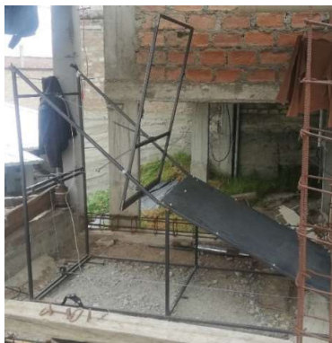
Construcción de Estructura Parvati
