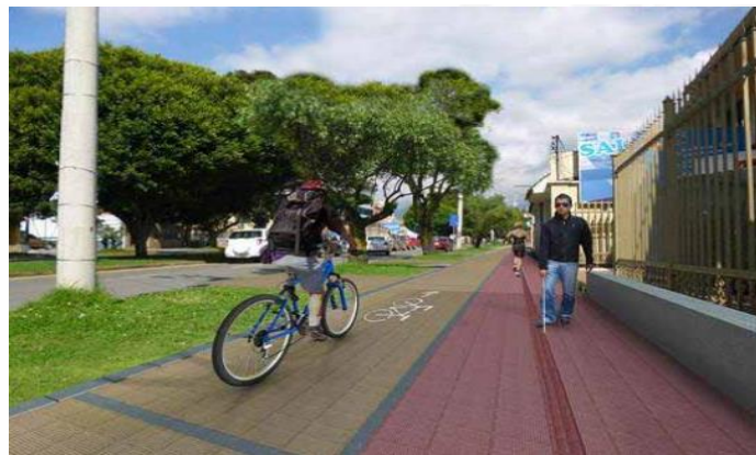
Ilustración 5 Acera – bici Cuenca - Ecuador Fuente: GAD Municipal de Cuenca
