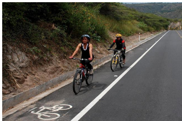
Ilustración 4: Ciclovía en Espaldón Ibarra - Ecuador
