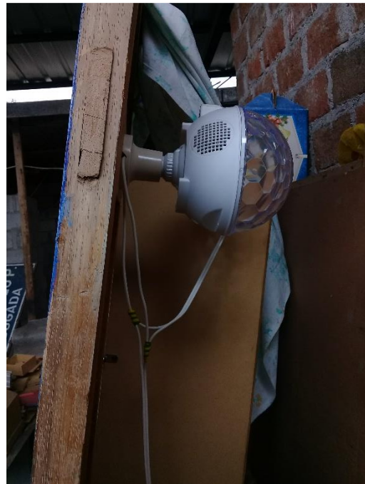
Imagen 92. Espejo, F. 2020. Proceso de instalación de bases y ensamble de conexiones de luces y parlante. [Ensamblaje].
