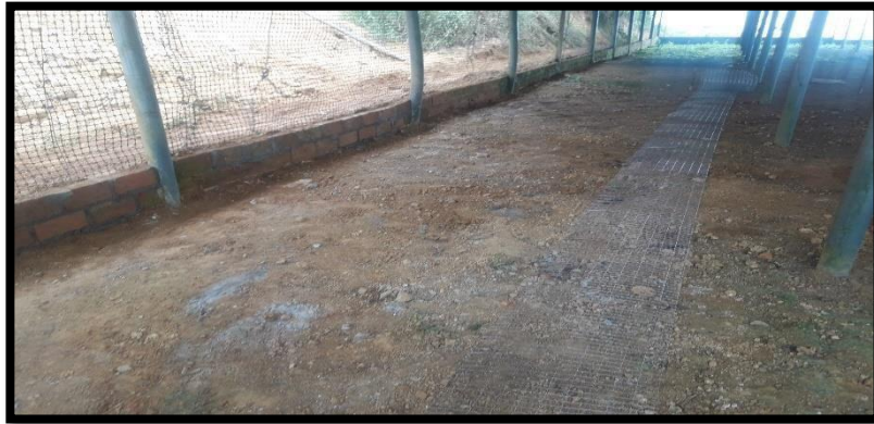
Ilustración 1. Construcción de las jaulas
