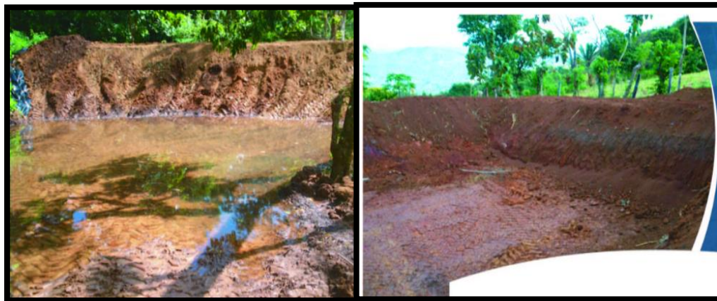
Figura 7. Reservorio Excavado Fuente: CEMEDE y UNED (2009)
