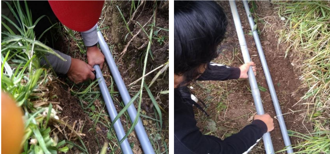
Figura 22. Instalación de la tubería principal.
