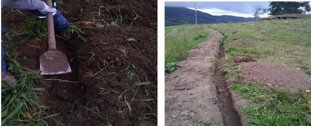
Figura 20. Excavación de zanjas y preparación del terreno.
