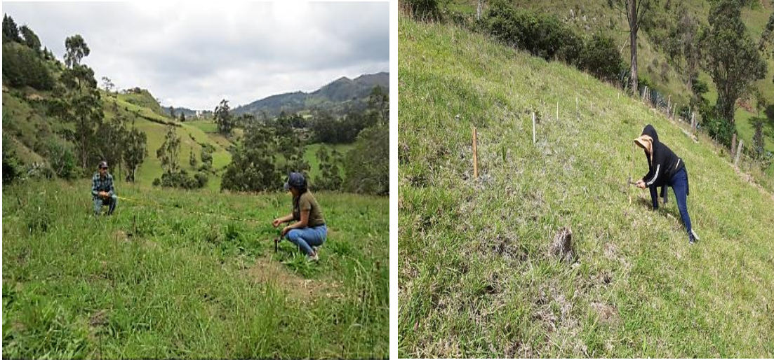
Figura 18. Señalización de la ubicación de la tubería en campo.
