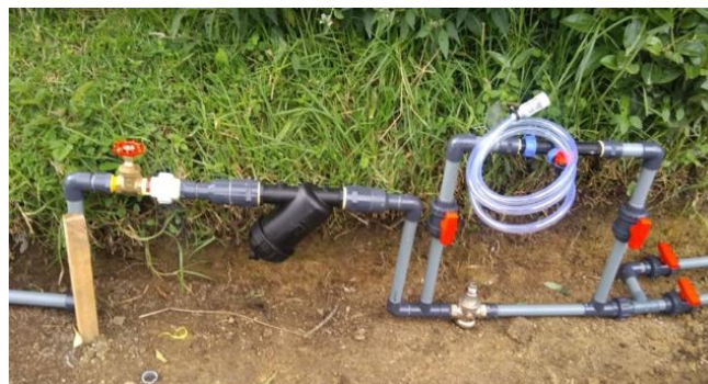
Figura 21. Cabezal de riego: sistema de filtrado y fertirrigación.
