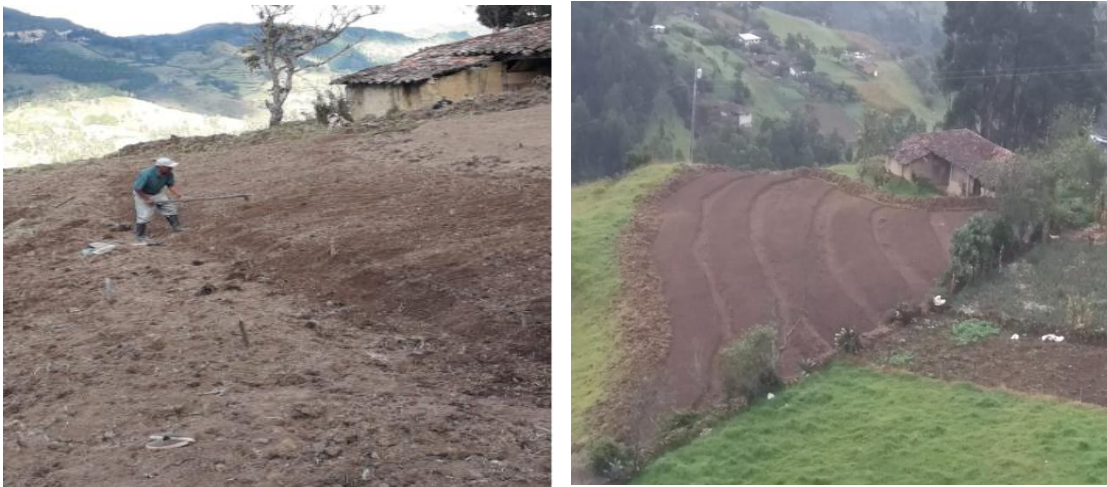
Figura 19. Preparación del terreno para la instalación del sistema de riego por microaspersión
