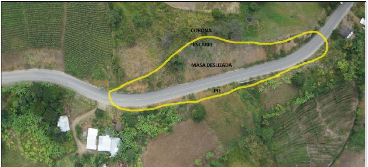
Fotografía 28: Deslizamiento D-3 Fuente: La autora, 2019
