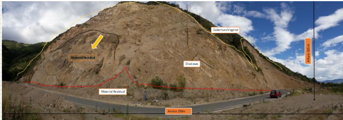
Fotografía 14: Toba Andesítica con medio grado de meteorización. Vista NE-SW Fuente: La autora, 2019
