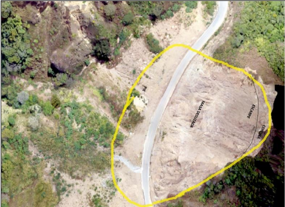
Fotografía 27: Deslizamiento D-2 Fuente: La autora, 2019
