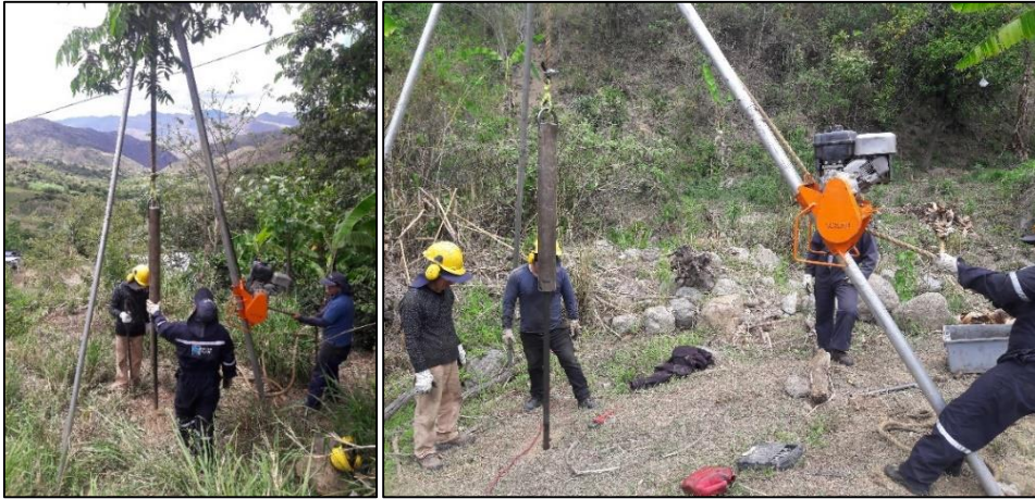
Fotografía 4: A) Ensayo SPT 1 B) Ensayo SPT 2
