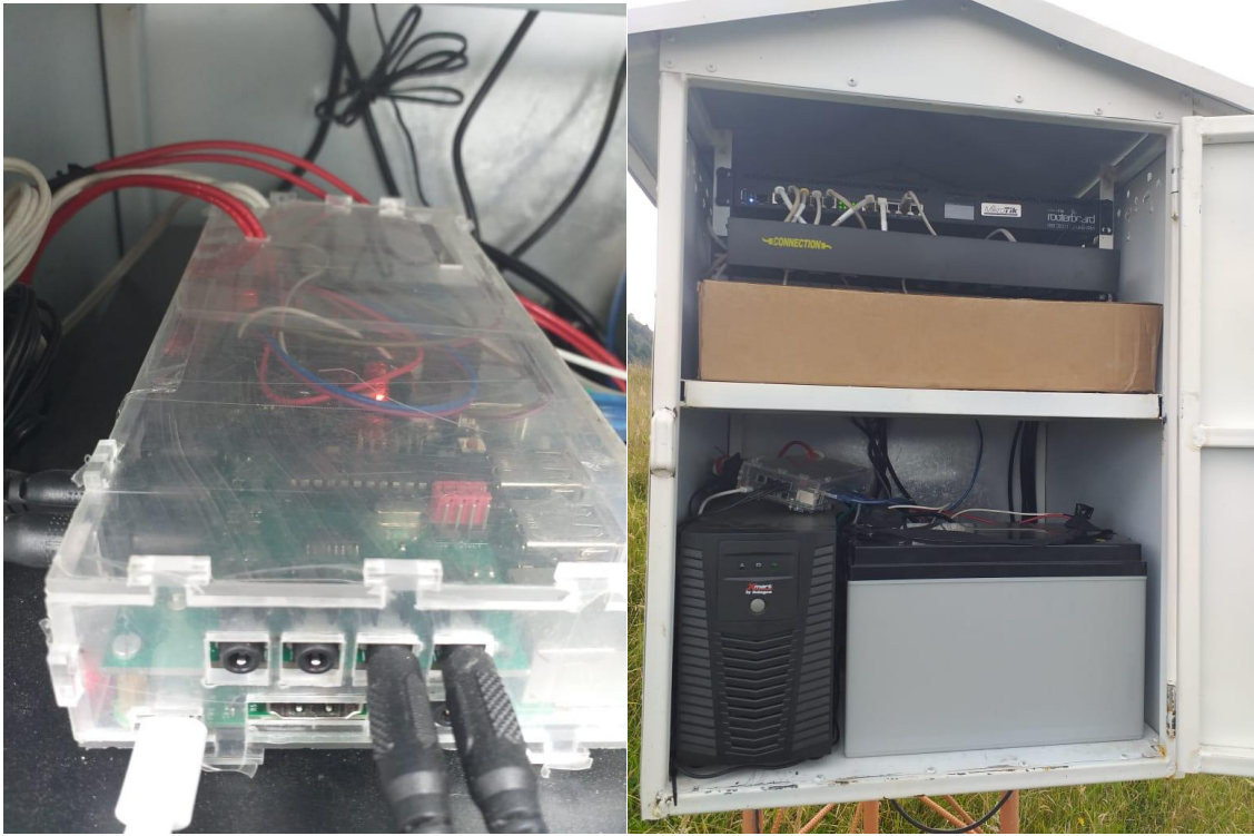
Figura 48. Armado del sistema de monitoreo de parámetros eléctricos.
