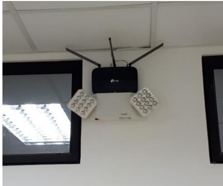
Figura 85. Ubicación del punto de acceso en pasillo. Fuente: Autor.
