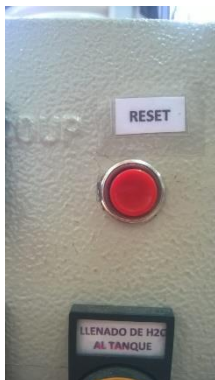
Figura 108. Pulsador NO para resetear el sistema de bombeo y reanudar los ciclos. Fuente: Autor.
