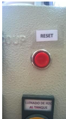
Figura 95. Pulsador NO para resetear el sistema de bombeo y reanudar los ciclos. Fuente: Autor.
