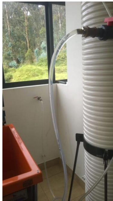
Figura 61. Conexión de la línea de carga de agua hacia la reserva a una red en el laboratorio.
