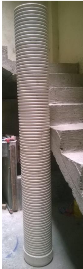
Figura 58. Tanque de reserva de agua para la sumersión de la bomba neumática. Fuente: Autor
