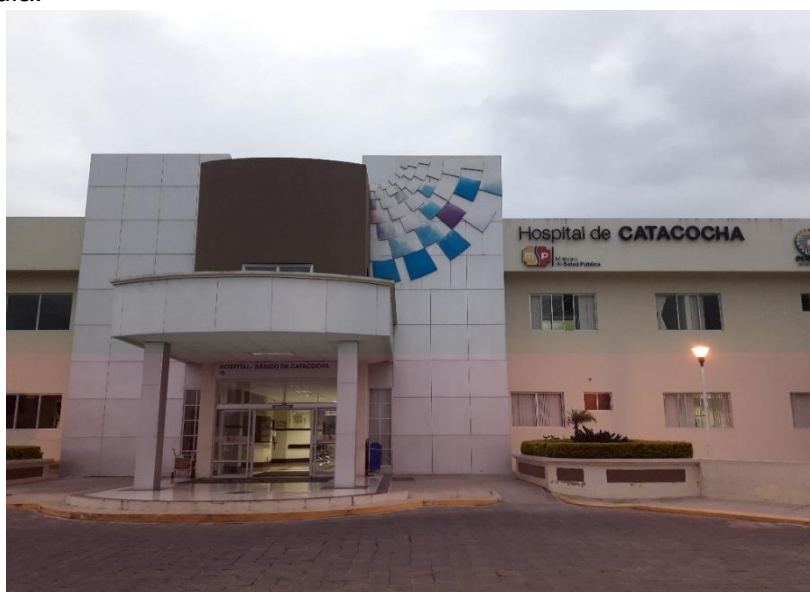
Figura 4. Hospital de Catacocha (Imagen propia).
