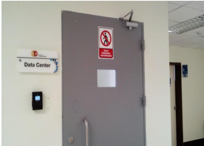
Figura 8. Puerta de Ingreso al Datacenter (Imagen Propia).
