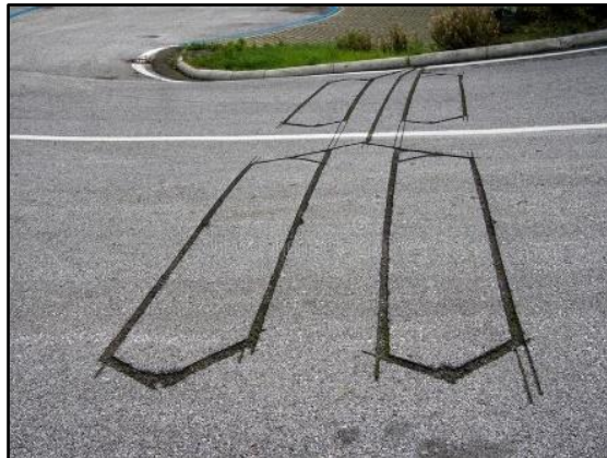
Figura 5. Sensores Piezoeléctricos en asfalto. Fuente: El autor.
