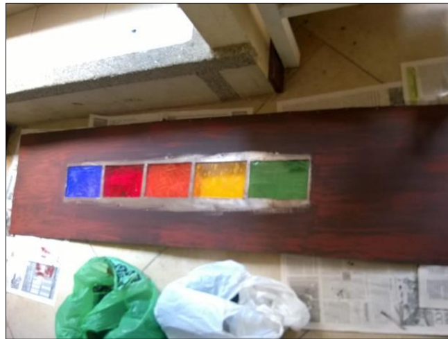
Figura 98. Pintado de la estructura, efecto madera con pintura anticorrosiva.
