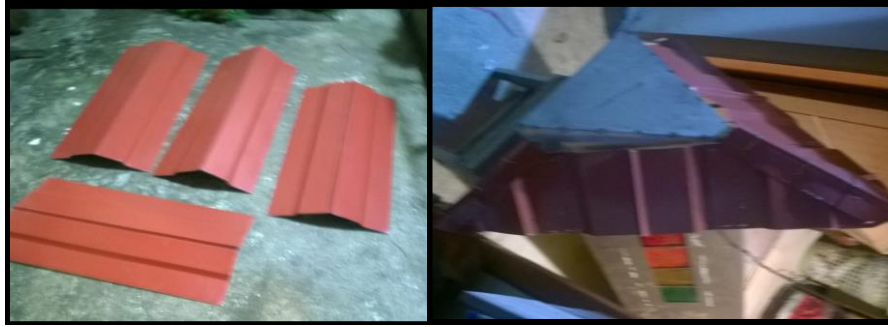
Figura 96. Recorte de y colocación de zinc tipo teja sobre el solmáforo.
