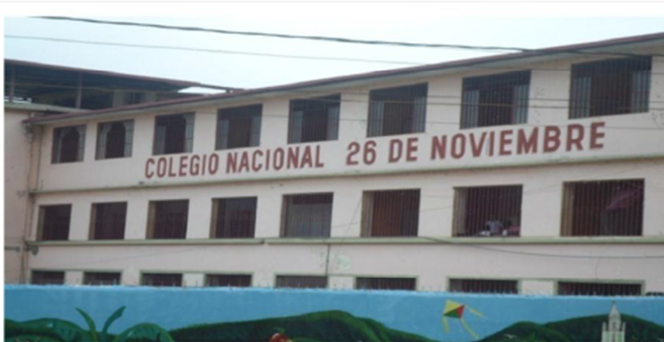
Fotografía 1: Infraestructura del Colegio 26 de Noviembre
