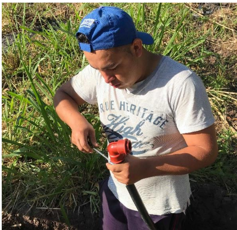
Anexo 2 Instalación del sistema de riego.
