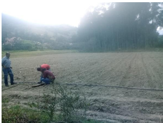
Figura 1. Instalación del sistema de riego por goteo (26/10/2018).
