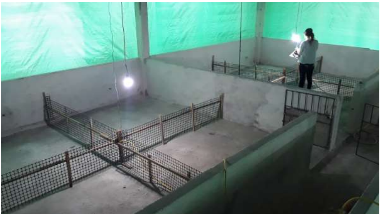
Figura 12. Colocación las campanas de gas
