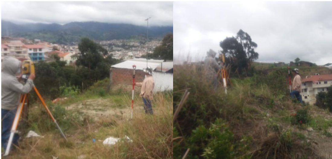
Fotografía 1. Levantamiento topográfico del área de estudio
