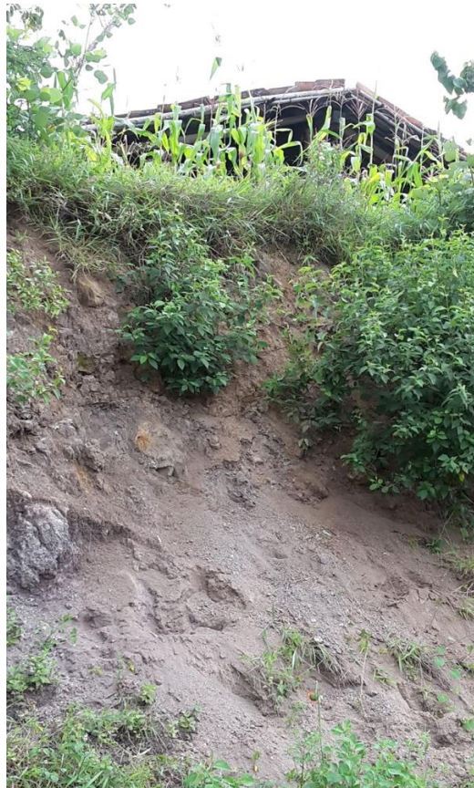
Anexo 4. Falta de adoquinado al acceso de la vivienda.
