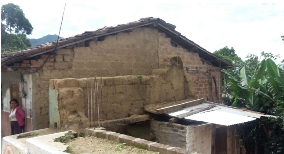
Anexo 2. Viviendas construidas con adobe.
