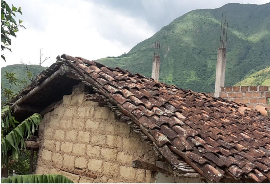
Anexo 3. Techo de teja.
