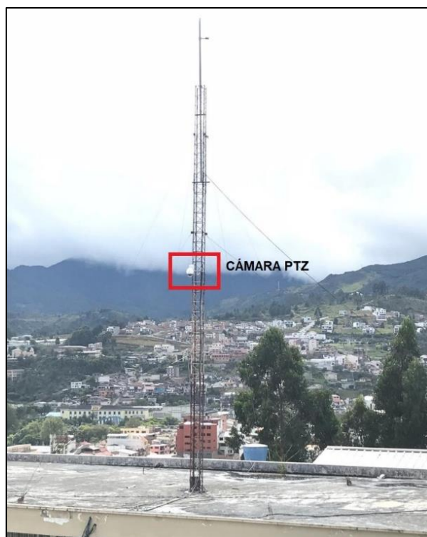
Figura 16. Imagen de la ubicación de la cámara PTZ en el bloque 3 de la facultad. Fuente: La Autora.
