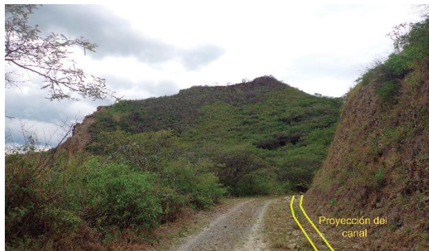
Fotografía 31. Tramo de la vía para la proyección del canal de riego Fuente: El Autor, 2019
