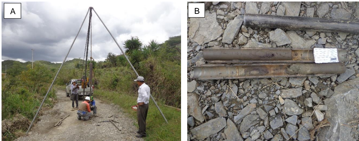
Fotografía 5. A) Colocación de equipo SPT B) Etiquetado de muestra
