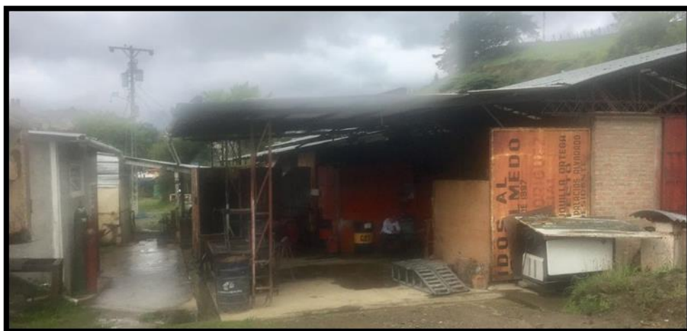
Figura 15. Área de soldadura
