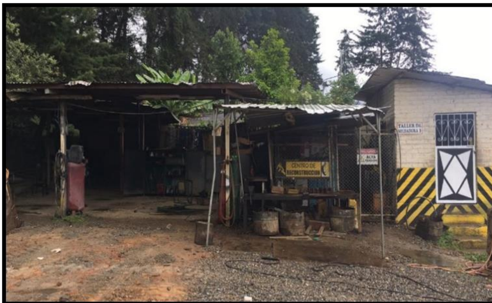
Figura 10. Taller de soldadura
