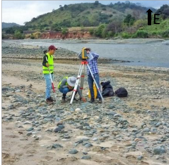
Fotografía 1. Punto de partida del levantamiento topográfico
