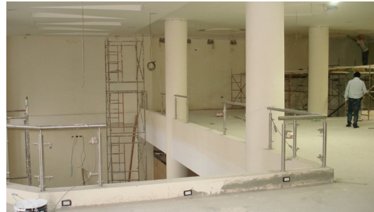
Vista general interna del mezzanine de Edificio Comercial “Calipso”
