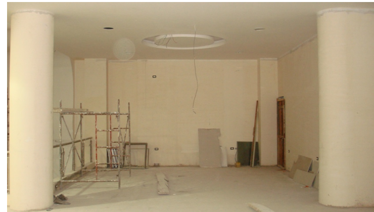
Vista frontal del área a trabajar en el Edificio Comercial “Calipso”.
