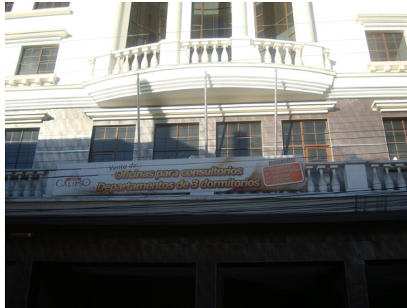
Vista Frontal del Edificio Comercial “Calipso”
