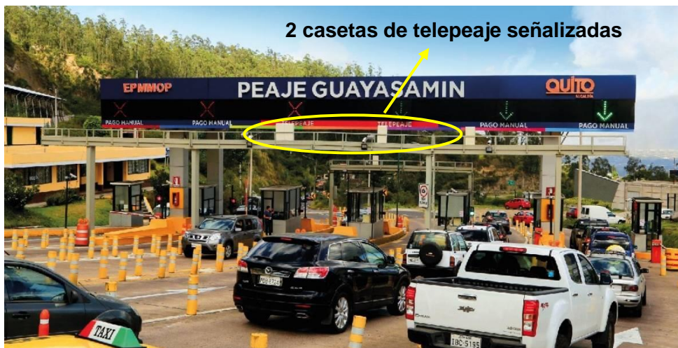
Figura 1 Telepeaje del túnel Oswaldo Guayasamín [10]
