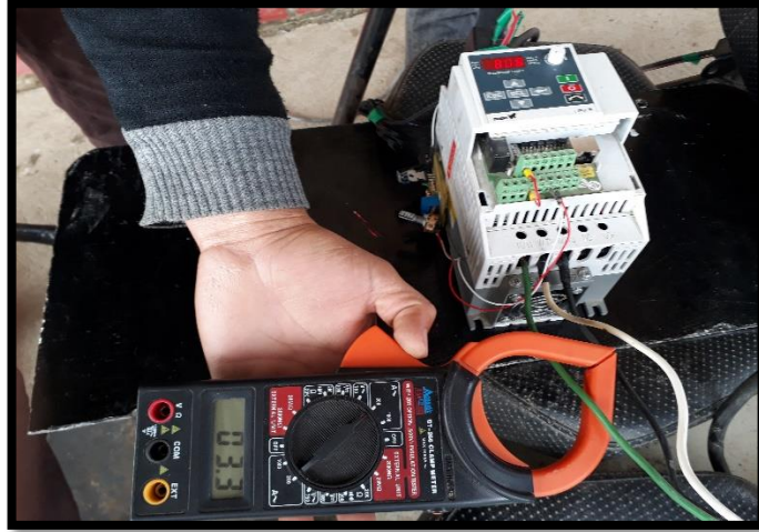
Figura 30: Medición del amperaje con la pinza amperimétrica
