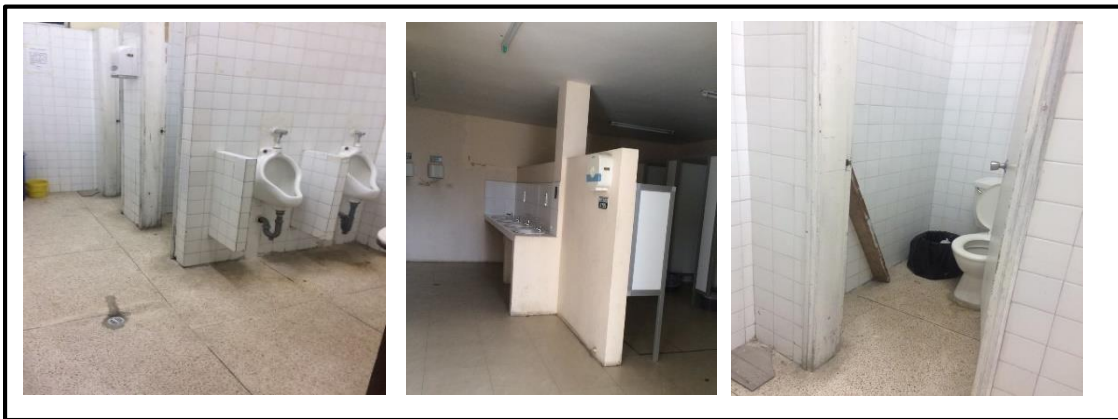
Figura 30. Servicios Higiénicos Campus Universitario.
