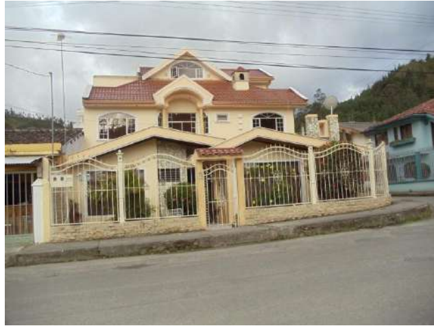
FACHADA MODERNA DE ZORA HUAYCO
