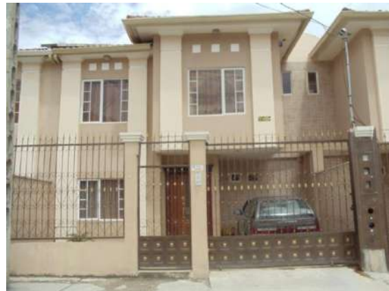
CONSTRUCCIONES NUEVAS EN YAHUARCUNA
