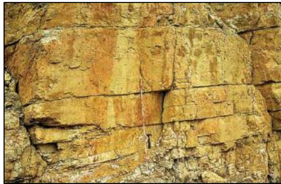
Figura 2. Superficies de estratificación horizontales de gran continuidad en macizo rocoso calizo.
