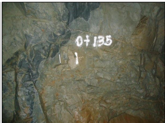
Fotografía 6. Contacto entre basalto y cuarzoandesita porfídica de hornblenda.
